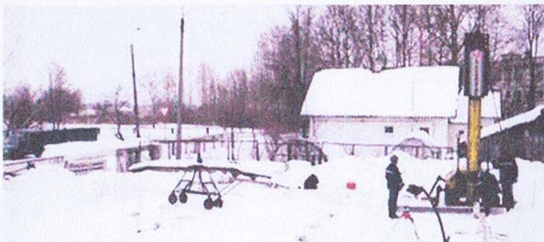
Свай вставляется в ударный механизм. Одна свая забивается в грунт за несколько минут. Забивка свай контролируется специалистами с помощью нивелира.
