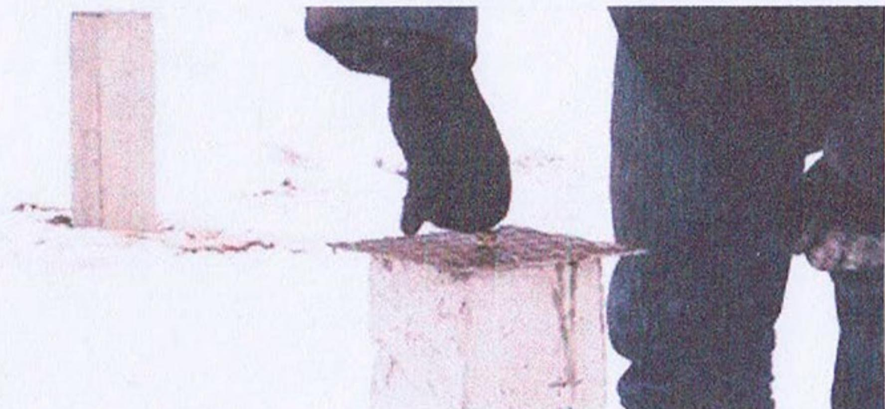
Дополнительно, поверх забитой сваи можно смонтировать на анкеры металлическую пластину, на которую потом ляжет обвязочный брус или швеллер. Или сваю можно раздробить на конце до арматуры, для последующего возведения железобетонного ростверка.
